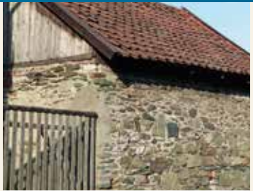
Vulkanite bzw. Schalstein als Baumaterial
