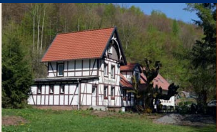
Braunsteinhaus (tidligere administrationsbygning)
