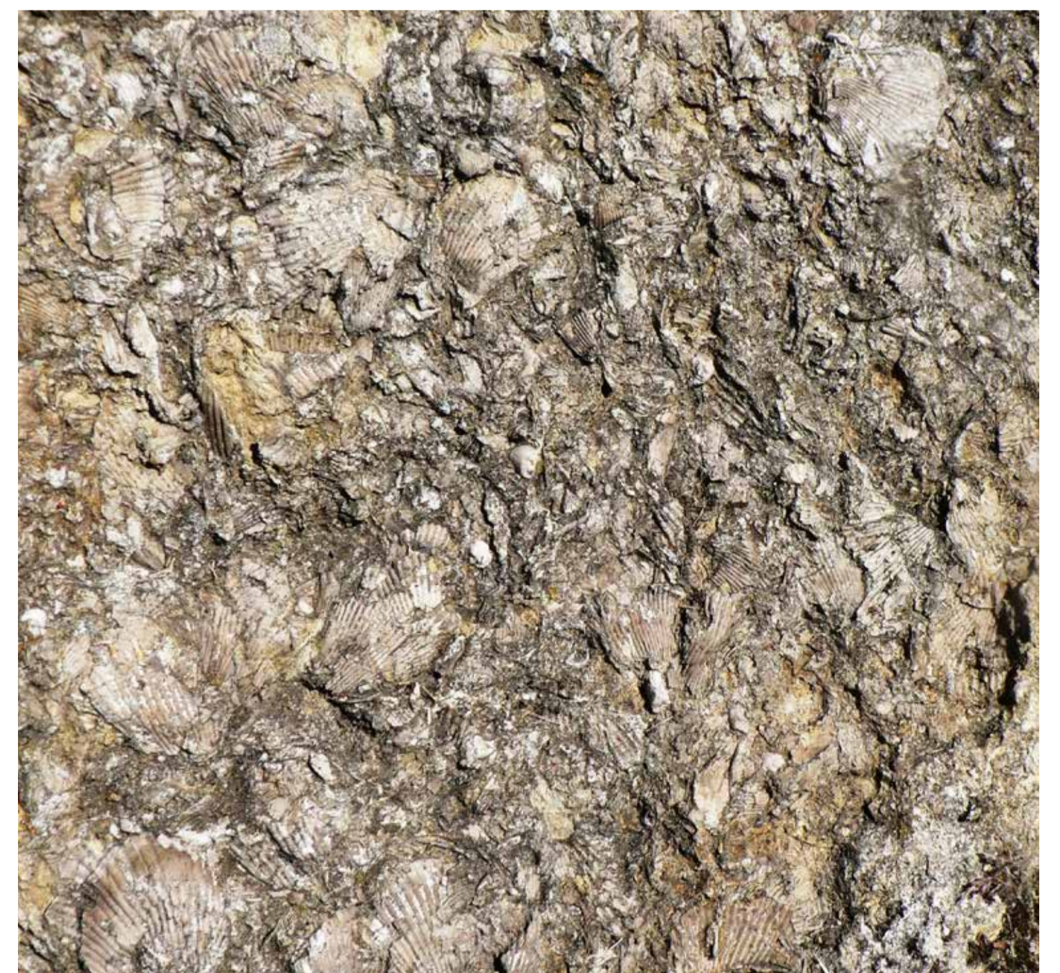
Muschelkalk im Mauerwerk des Schlosses
