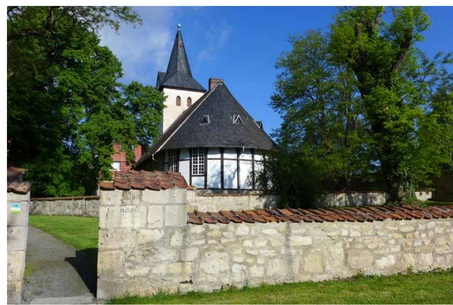
In der Mauer und im Kirchturm erkennbar: Muschelkalk Recognisable in the wall and the spire: shell limestone
