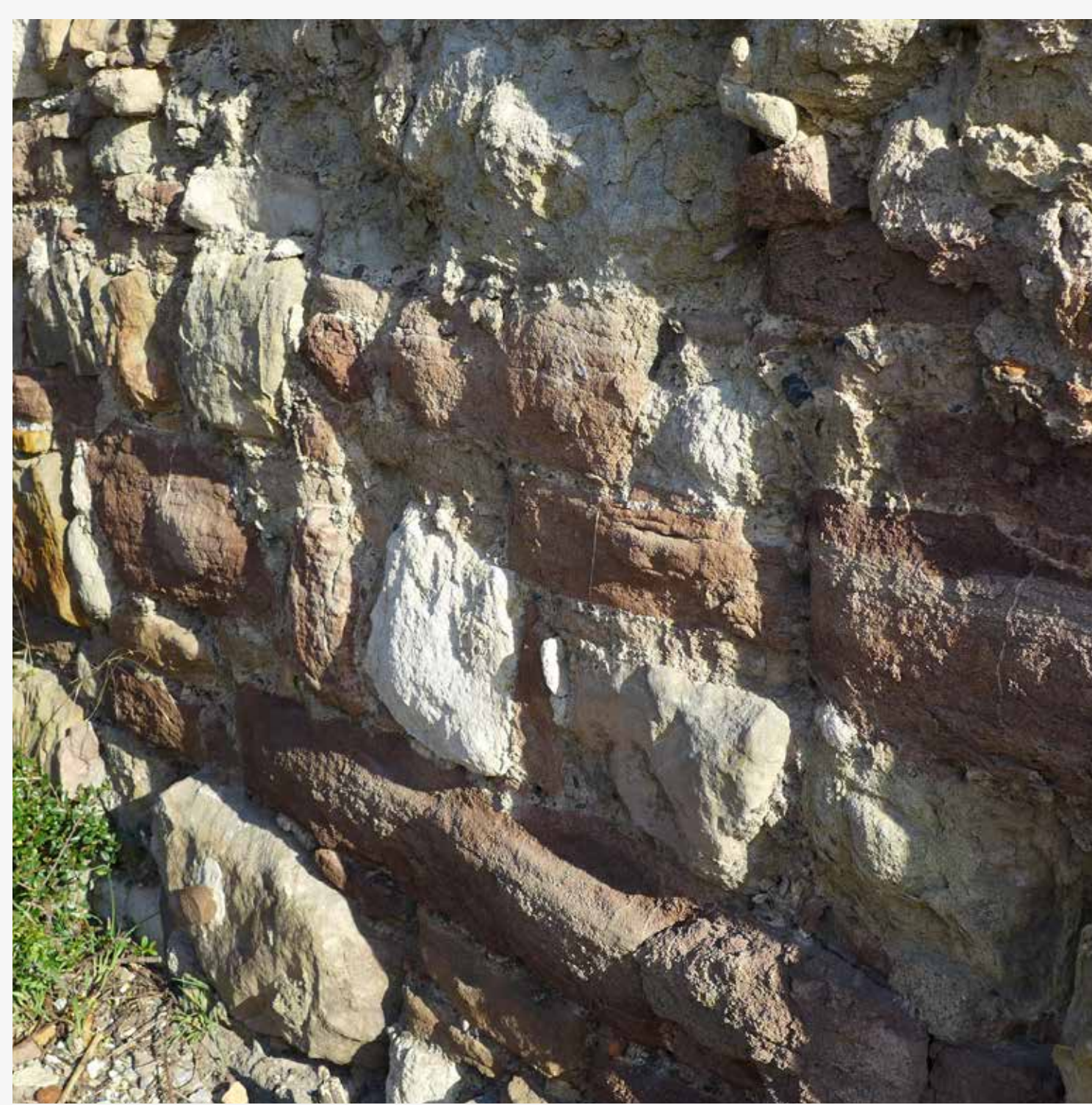
Mischmauerwerk aus heimischem Sandstein, Rogenstein und Muschelkalk
