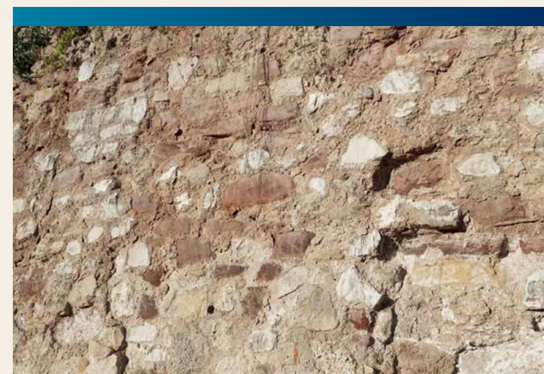
Heller Dolomit und rötlicher Buntsandstein im Mauerwerk
