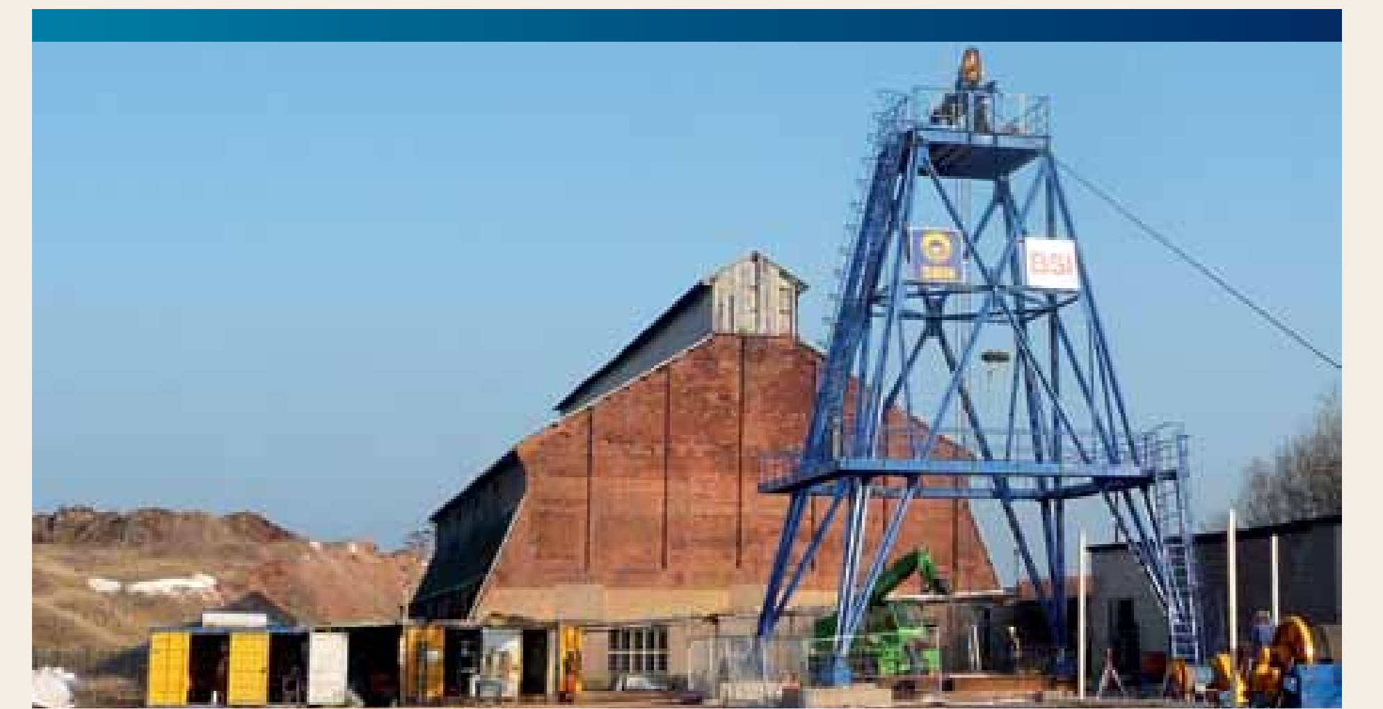
Schachtgerüst und Salzspeicher während der Verwahrungsarbeiten 2011 bis 2013
