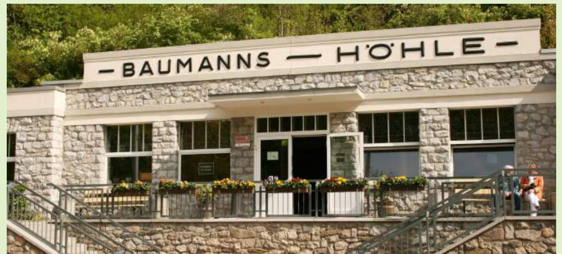
Eingang zur Baumannshöhle Entrance to Baumann's Cave
