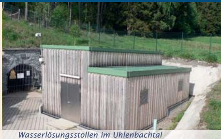
Wasserlösungsstollen im Uhlenbachtal
