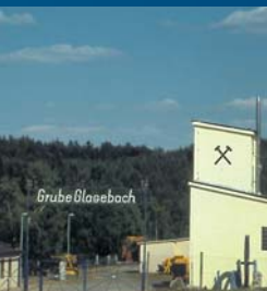
Tagesanlagen der Grube
