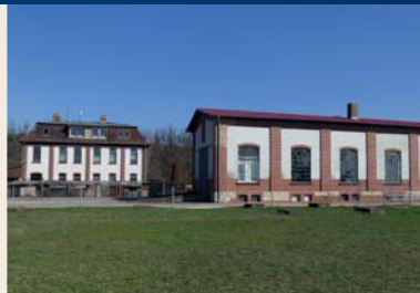
Maschinenhalle Schacht „Neu-Mansfeld“
