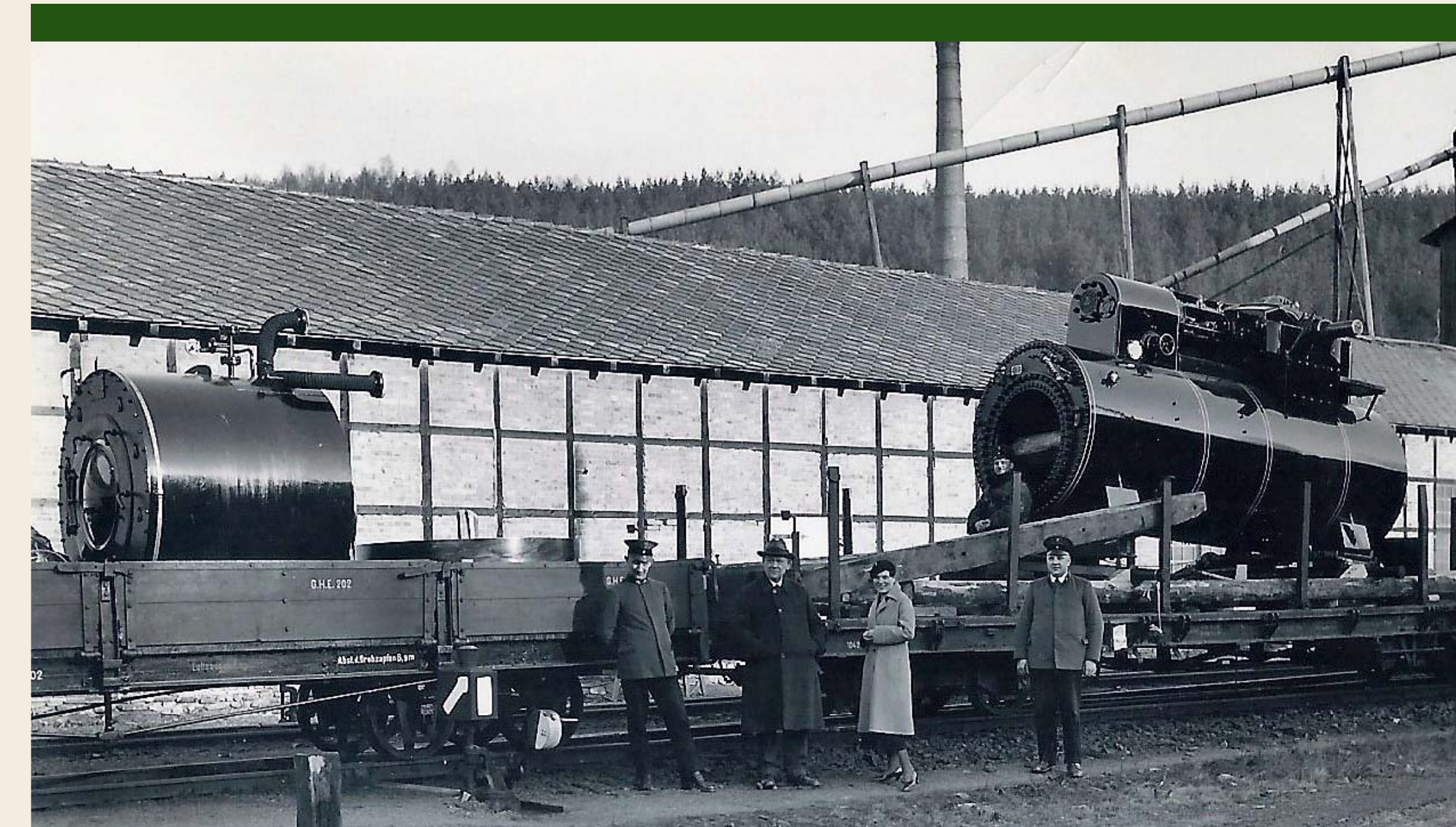
Kesselanlieferung zur Rinkemühle
