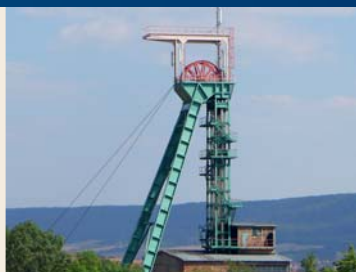
Echafaudage de puits Sollstedt
