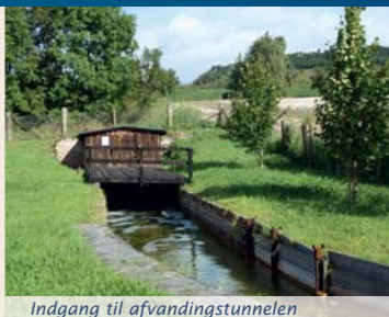
Indgang til afvandingstunnelen
