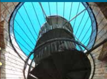
Spindeltrappe i Hausmannsturm
