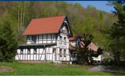
Braunsteinhaus (ehemaliges Zechenhaus)
