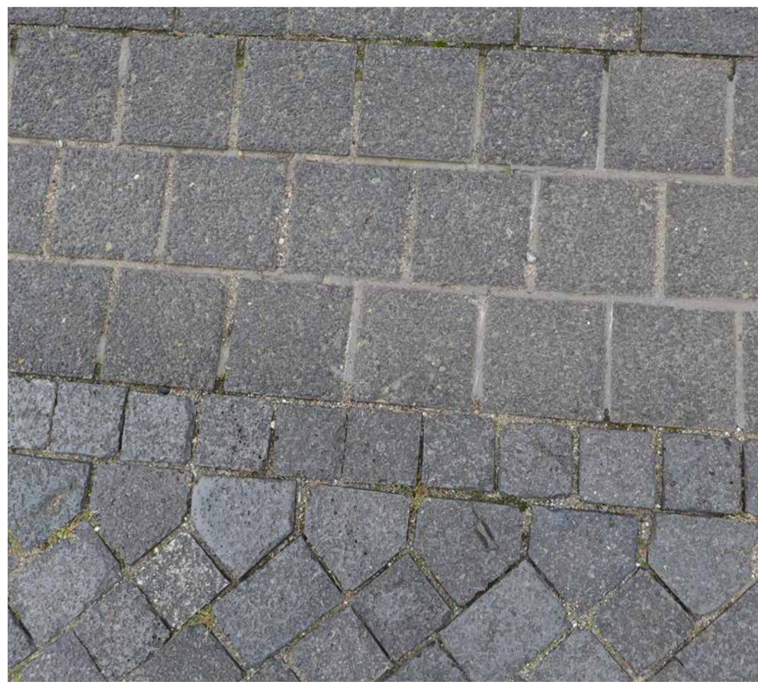
Straßenpflaster aus Schlacke „-steinen“ Slag pavement
