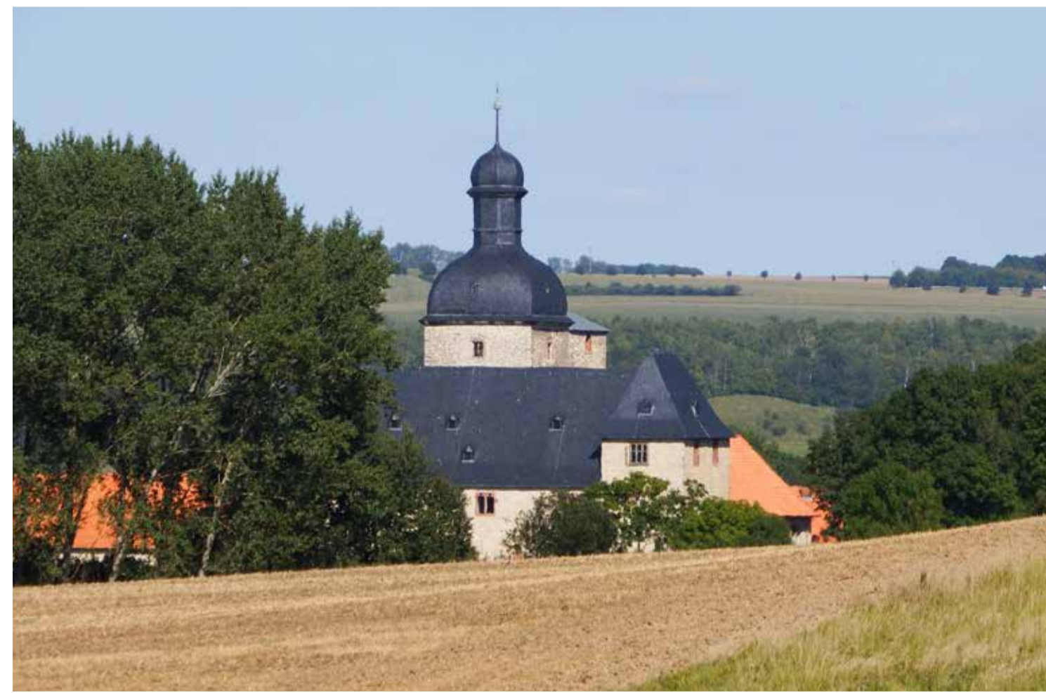
Die mittelalterliche Wasserburg wurde in der Neuzeit zu einem bedeutenden landwirtschaftlichen Gut. The medieval moated castle became an important agricultural estate in the modern era.
