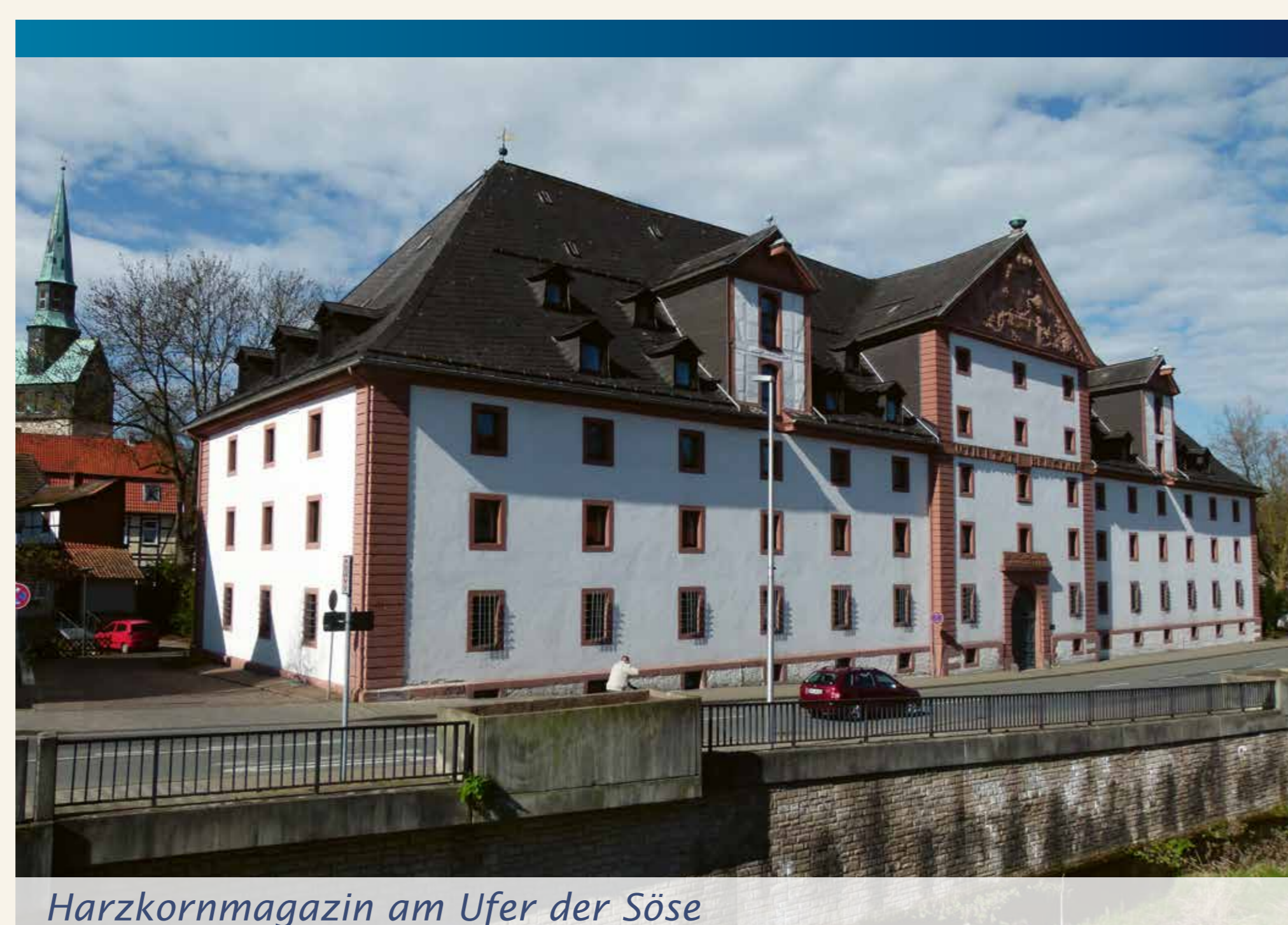
Harzkornmagazin am Ufer der Söse
