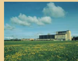
Puits Fluorschacht au nord de Strassberg
