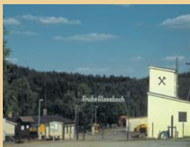
Installations de surface de la mine Glasebach
