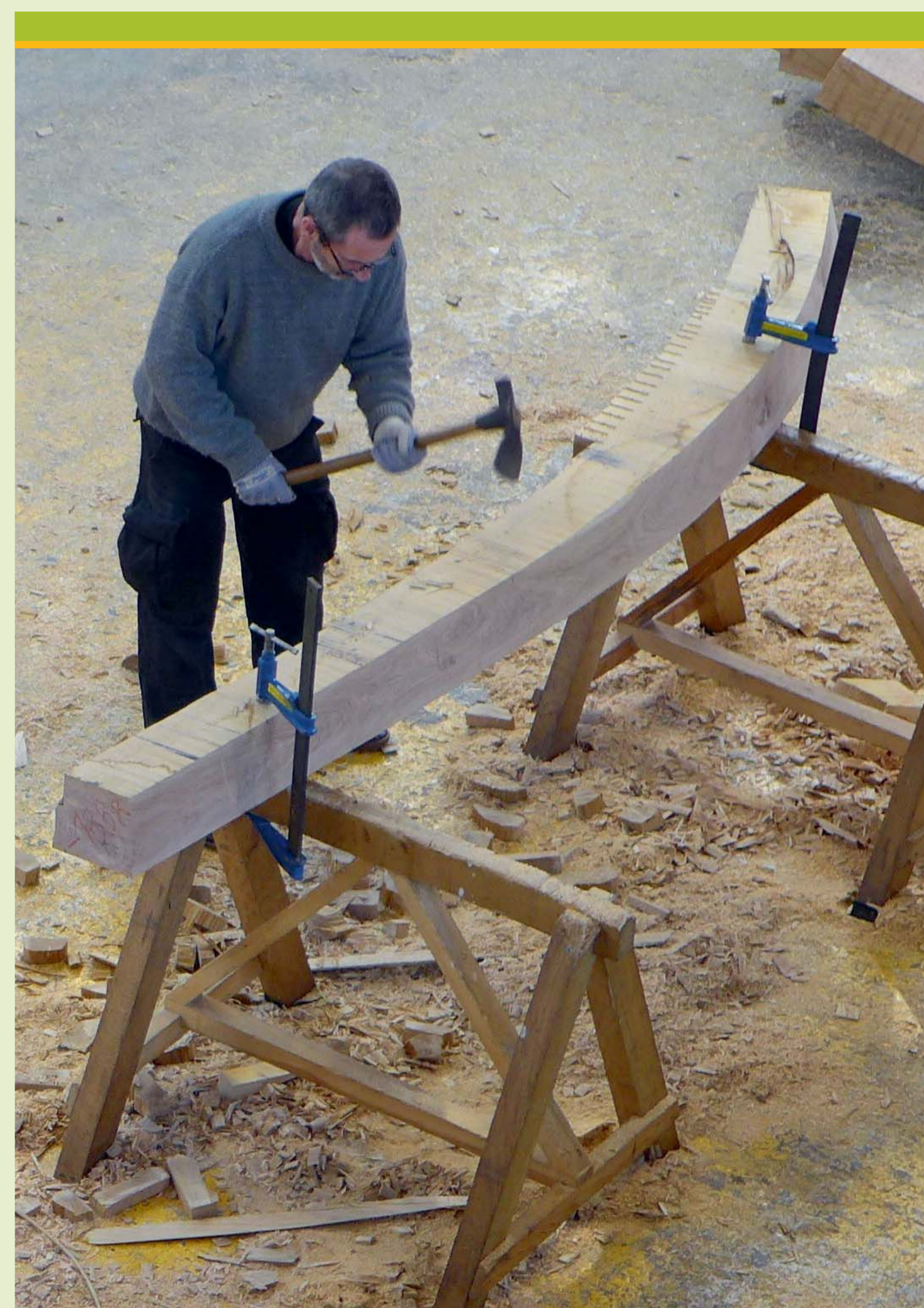
Nur selten werden heute noch Balken mit einer speziellen Axt behauen.
