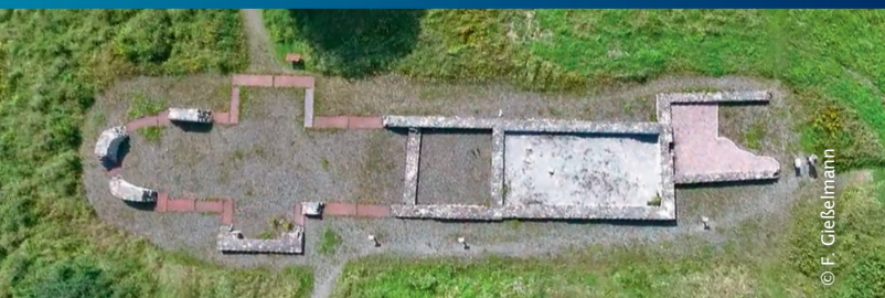
Grundmauern der Kapelle mit Zwischen- und Estrichbau
