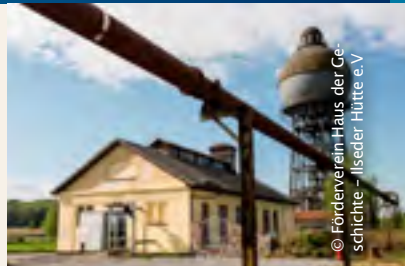
Umformerstation mit Wasserturm
