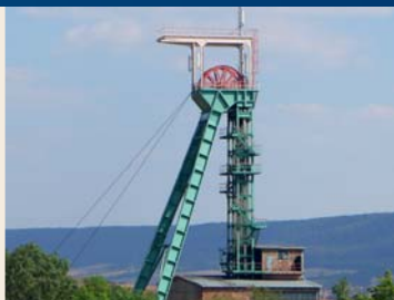
Elevatorstårn i Sollstedt
