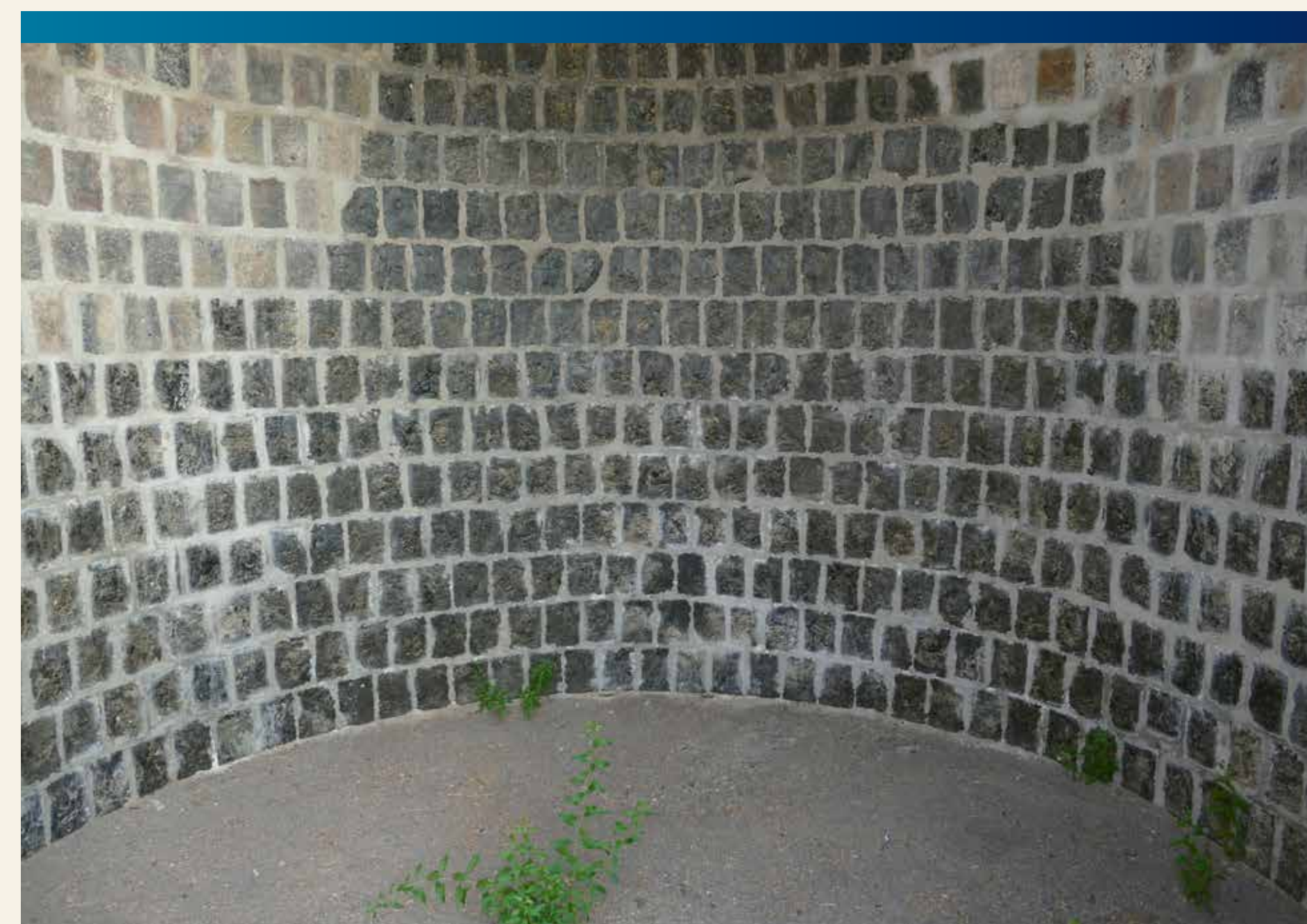
Verfugte Schlacke („-steine“) im Inneren der Kornflasche
