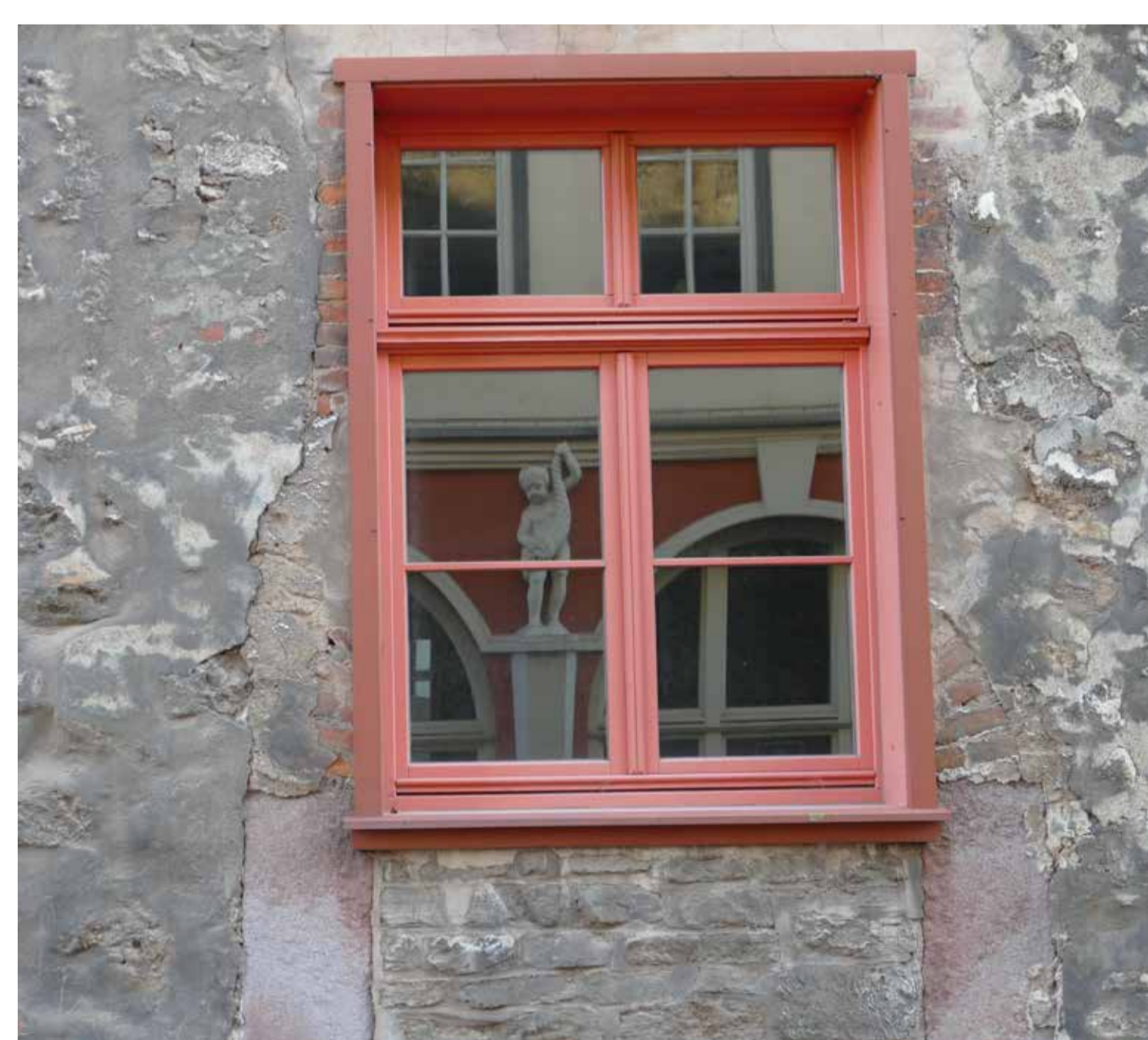
Sandstein, Ziegel und Dolomit im Mauerwerk des Walkenrieder Hofes (Dr.-Külz-Straße) Sandstone, brick and dolomite in the walls of Walkenrieder Hof (Dr.-Kuelz-Strasse)
