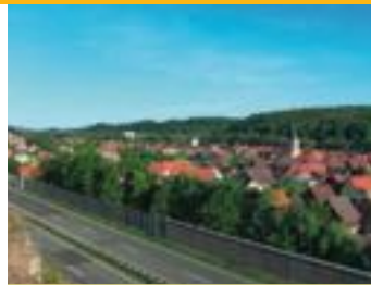
Erst die Schnellstraße unterqueren
