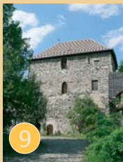
Wohnturm Burg Gatersleben
