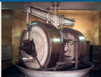
Kollergang in der Pulverfabrik
