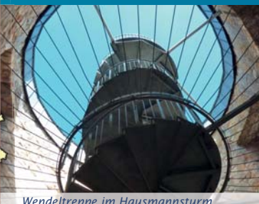
Wendeltreppe im Hausmannsturm
