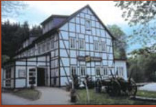
Hotel & Restaurant Kalkhütte Urbach – Alter Stolberg www.kalkhütte.de ☎ 036333 - 60870
