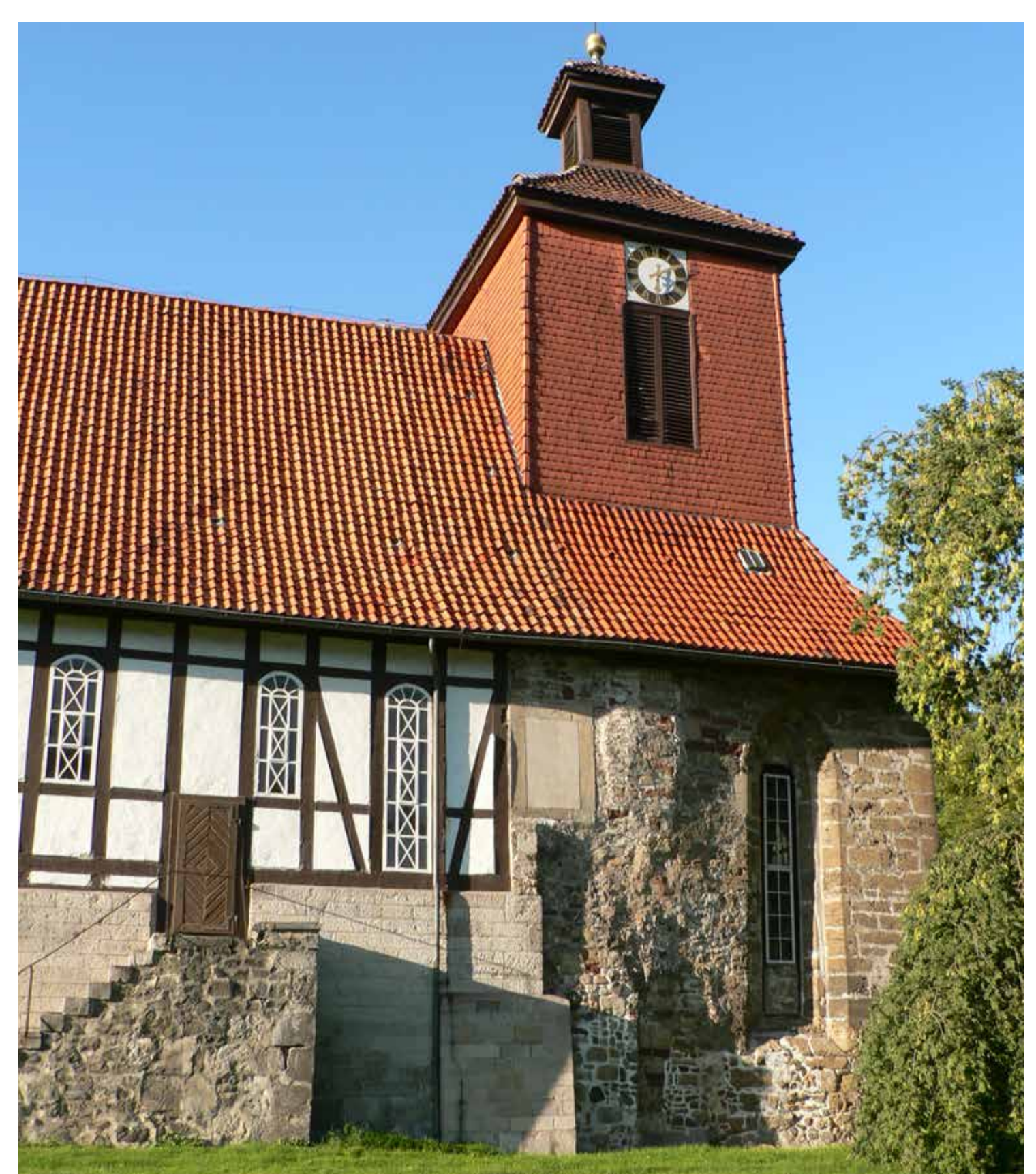
Dolomit und Buntsandstein im Mauerwerk der Kirche Pöhlde Dolomite and Bunter sandstone in the walls of Pöhlde Church
