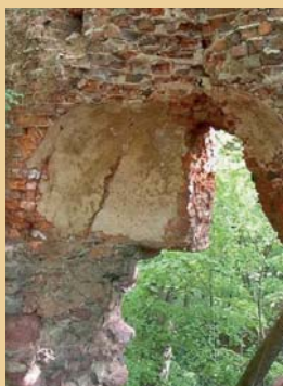
Reste des Mauerwerks
