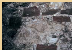
Buntsandstein, Gipsmörtel und Gipsblöcke: Wehrmauer Burg Lichtenstein
